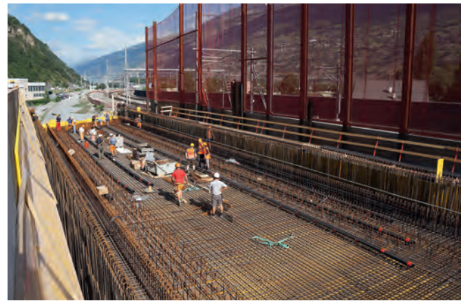
Fig. 3 Bewehrung des Brückentrogs. Reinforcement of bridge trough.
