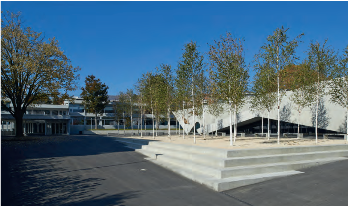
Fig. 2 Facciata Sud. South façade. (© Daniela Droz & Tonatiuh Ambrosetti)
