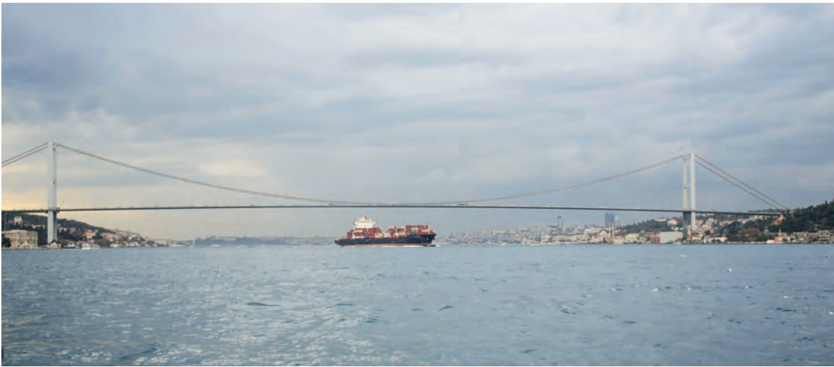
Fig. 1 Premier pont sur le Bosphore (1973) – Istanbul, une des premières applications des tabliers minces. First Bosphorus bridge (1973) – Istanbul, an early application of streamlined box girder.
