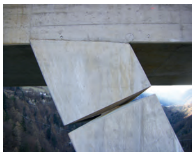
Fig. 4 Betongelenk. Concrete hinge.
