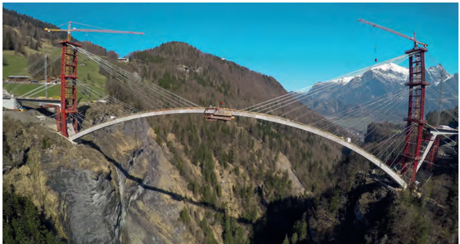
Fig. 6 Bogenschluss. Completion of the arch. (© Tiefbauamt Kanton St. Gallen)
