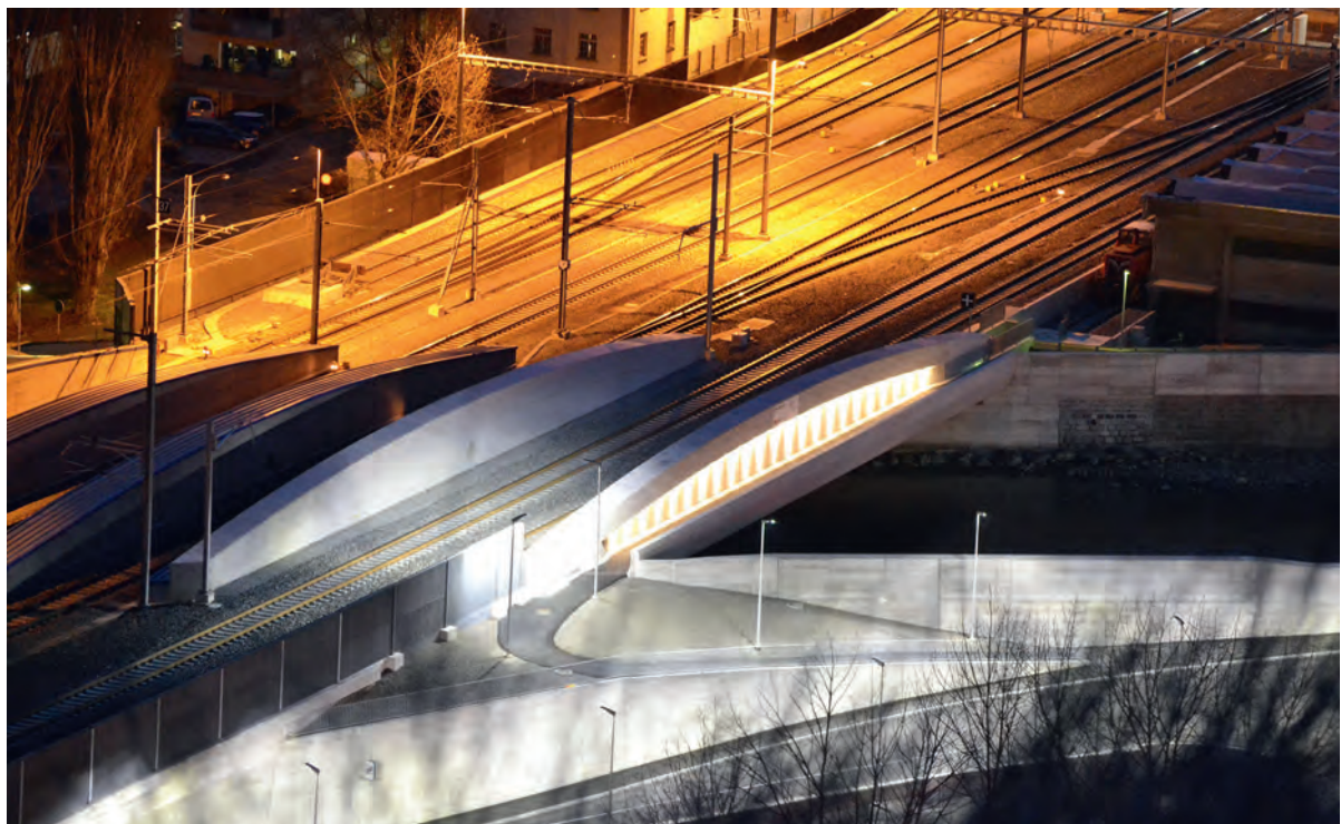
Fig. 1 Vierte Brücke über die Vispa. Fourth bridge over the Vispa river.
