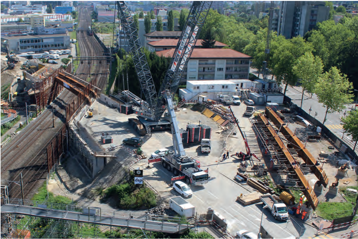
Fig. 7 Installationsplatz mit Raupenkran, erstes Trägerpaar eingehoben. Installation location with crawler crane, first set of girders set in place.
