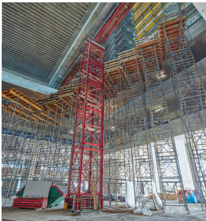
Fig. 7 Lehrgerüst der vorgespannten Treppen im Atrium der FHNW. Falsework for pretensioned staircases in the atrium of the FHNW. (© Martin Stollenwerk)
