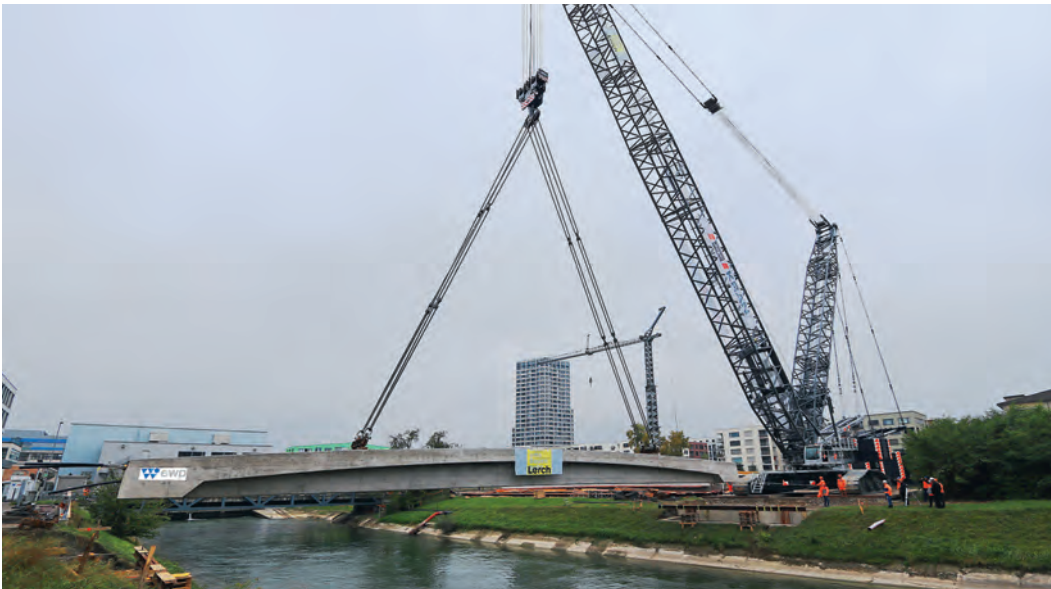
Fig. 4 Versetzen des ersten vorgefertigten und teilweise vorgespannten Längsträgers, Gewicht: 240 Tonnen, max. Tragvermögen des Raupenkrans: 750 Tonnen. Shifting the first pre-fabricated and partially prestressed longitudinal beam, weight: 240 t, max. capacity of the crawler crane: 750 t.
