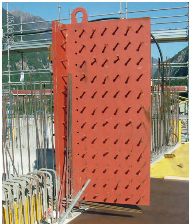
Fig. 7 Elemento metallico a bandiera per introduzione delle forze concentrate. Steel flag-profile for introduction of concentrated forces.
