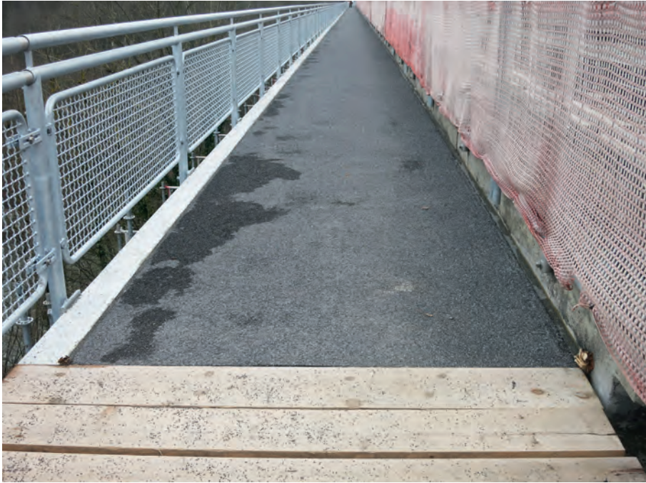
Fig. 8 Gehweg mit erneuertem Geländer, neuer Konsole und neuem Belag. Pathway with refurbished balustrade, new cantilever and new surface.
