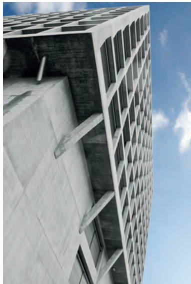
Fig. 8 Ring und Streben. Ring and braces.
