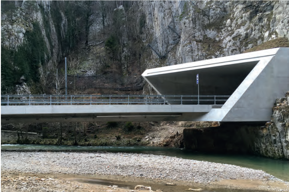
Fig. 10 Vue du portail et du tablier. View of the tunnel portal and the bridge deck.
