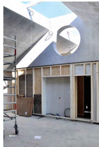
Fig. 5 Innenraum des Kindergartens mit den in Leichtbau ausgeführten nicht-tragenden Holzständerwänden. Interior of the kindergarten with lightweight-design, non-loadbearing timber stud partitions.
