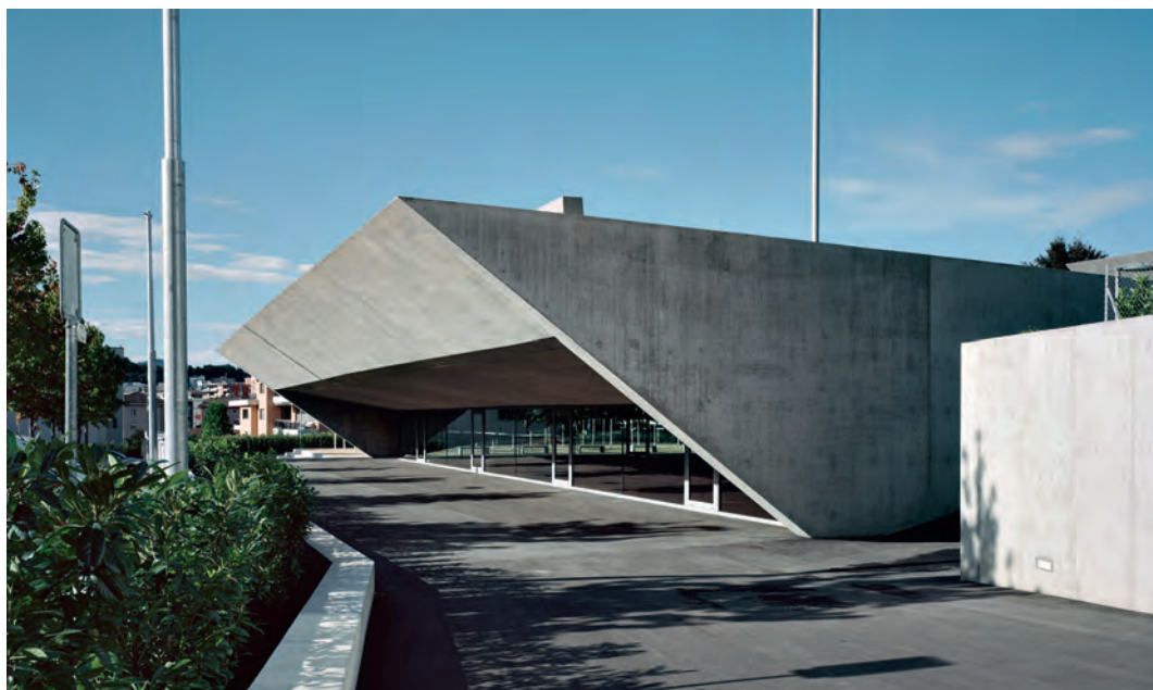
Fig. 3 Facciata Est e Nord. North and east façades. (© Daniela Droz & Tonatiuh Ambrosetti)
