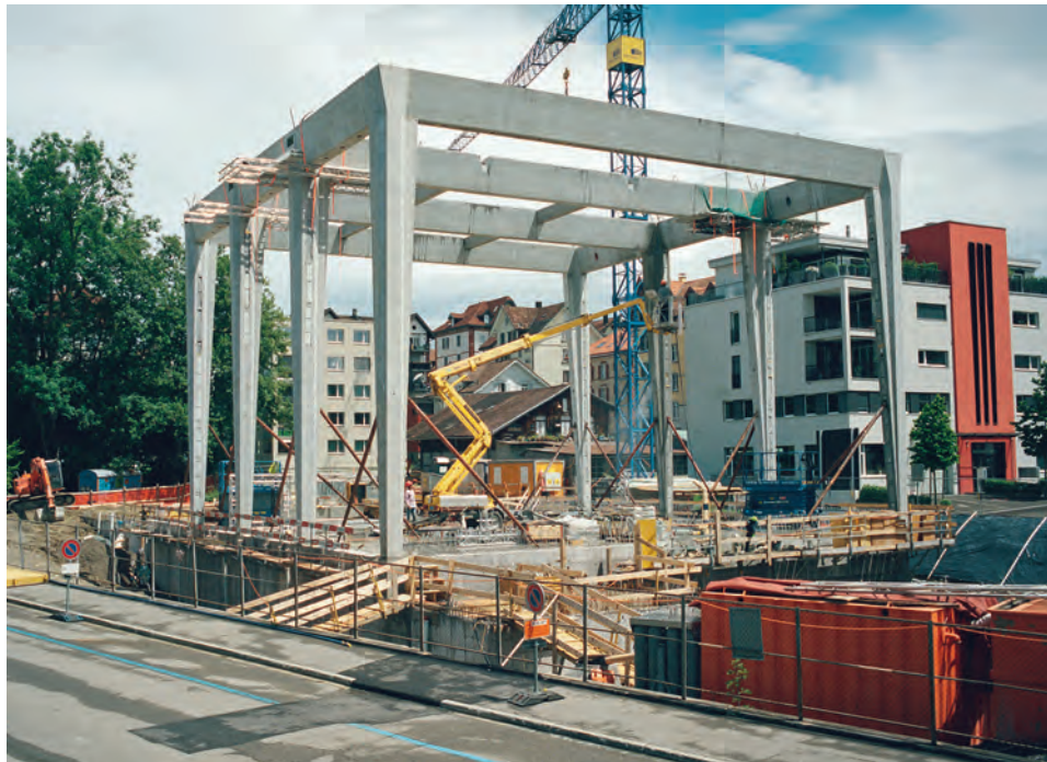
Fig. 5 Aufrichten des Betonrahmentragwerks. Erection of the load-bearing concrete structure. (Foto Katalin Deér)
