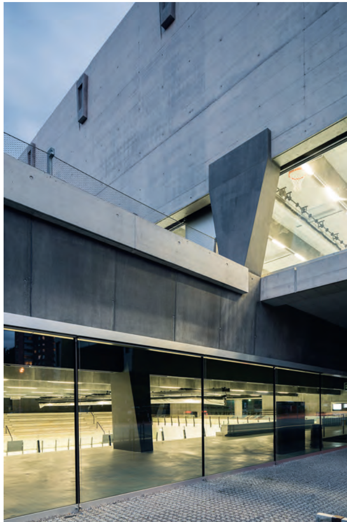
Fig. 2 Sicht in Wettkampfhalle mit Hauptstütze und Trainingshalle mit statisch aktivierter Aussenwand. View within the competition arena with main column and training hall with structurally activated external wall. (Foto: Dominique Marc Wehrli)
