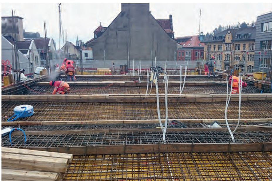
Fig. 6 Vista delle armature del solaio pieghettato. View of the reinforcement of the folded plate.
