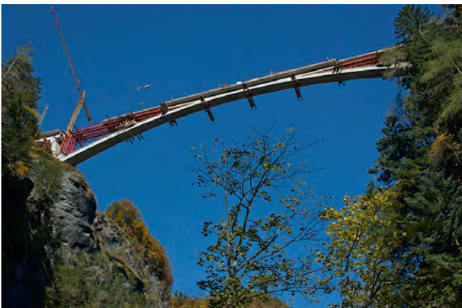
Fig. 7 Überbau auf Lehrgerüst. Superstructure on falseworks. (© Tiefbauamt Kanton St. Gallen)
