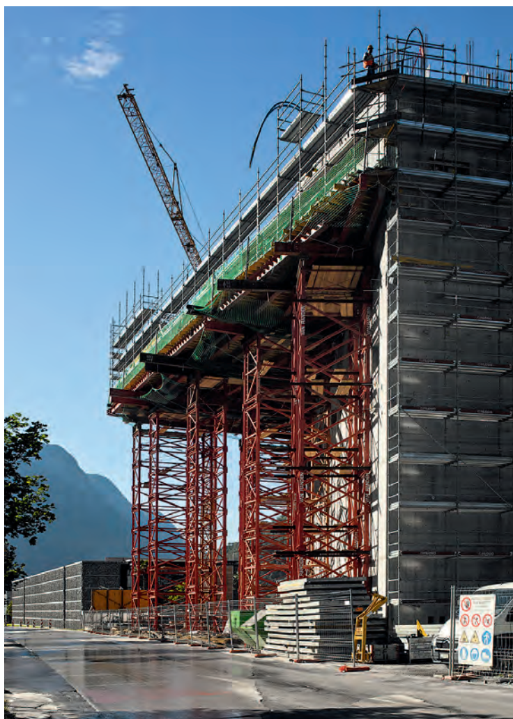
Fig. 3 Piattaforme per esecuzione delle parti aggettanti. Scaffolding for the cantilevered parts. (© ORCH – Alessandra Chemollo)
