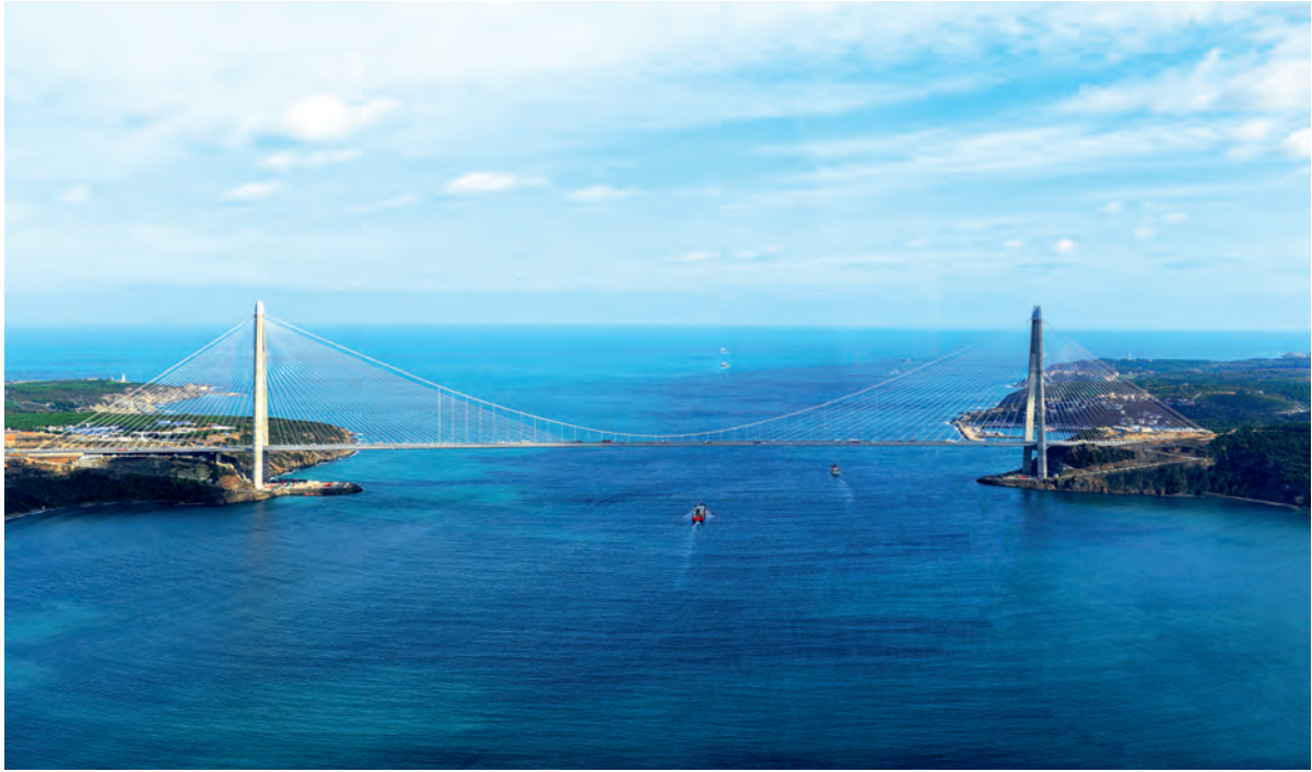
Fig. 3 Troisième pont sur le Bosphore: un pont suspendu à haute rigidité. Third Bosphorus bridge: a highly rigid suspension bridge.
