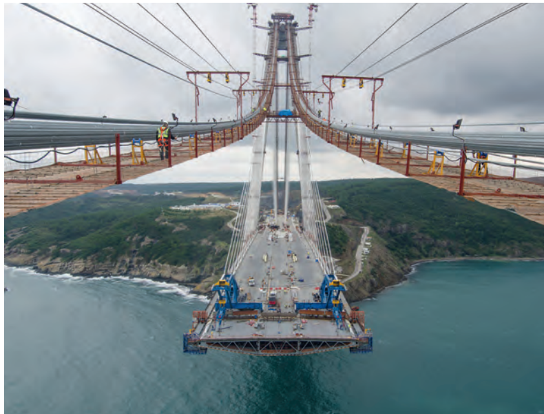
Fig. 8 Encorbellement de la zone haubanée avec installation des câbles principaux. Cable stayed cantilevering during cable installation.
