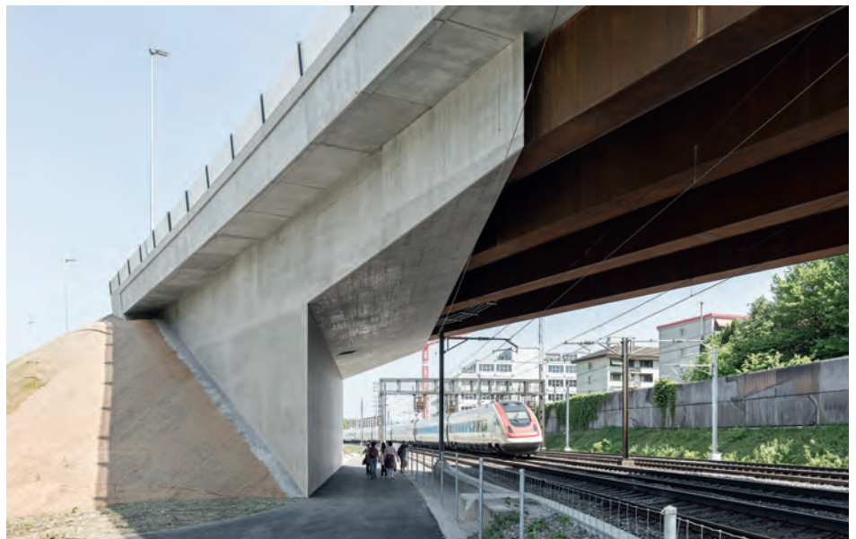
Fig. 2 Stark schiefwinklige Betonvoute beim Rad- und Gehweg mit eingespannten Stahlträgern. Very acute-angled concrete haunch at the cycle and foot path with restrained steel girders.
