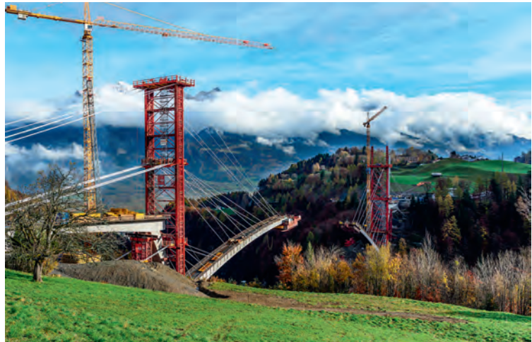
Fig. 5 Freivorbau im Wochentakt. Free cantilever construction on a weekly basis.
