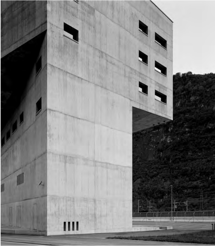
Fig. 2 Particolare del calcestruzzo facciavista sul fronte ovest. Detail of exposed concrete on the western facade. (© H el ene Binet)
