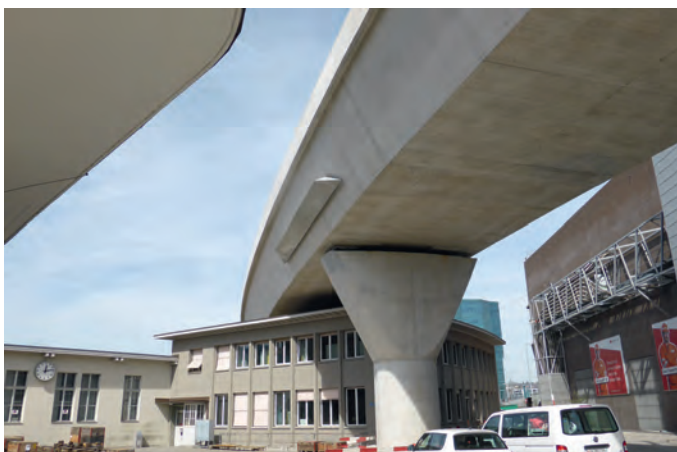
Fig. 5 Kohlendreieckbrücke – Überquerung des Hilfiger-Gebäudes. Kohlendreieck bridge – passing over the Hilfiger building.
