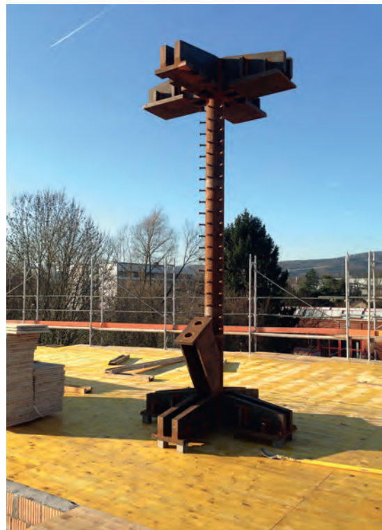
Fig. 5 Speziell konfektionierte, in den Beton eingelegte Stahlelemente. Specially developed steel elements inserted into the concrete.
