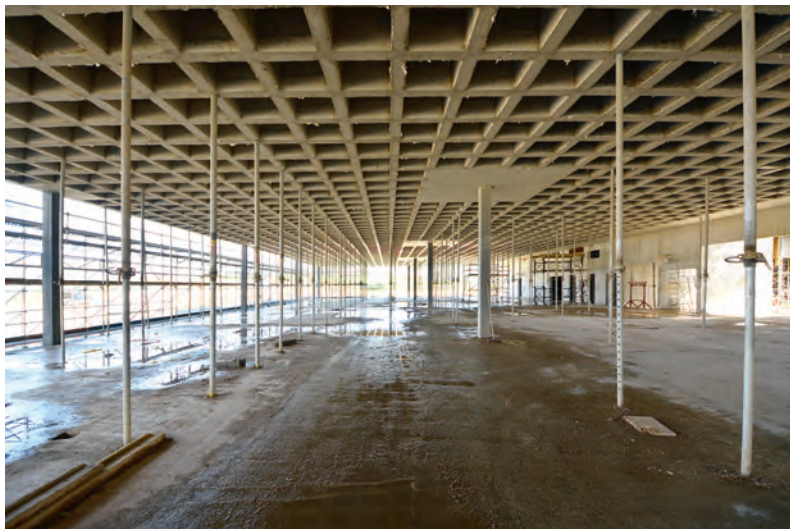
Fig. 8 Vue de la dalle cassette après décoffrage. View of the cassette slab after removal of formwork.
