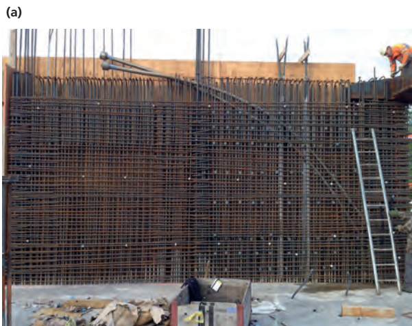
Fig. 6 Kraftverlauf in den hochbeanspruchten auskragenden Wandelementen: a) Bewehrung und Vorspannung, b) kontinuierliches Spannungsfeld, c) Plandarstellung. Force curve in the highly stressed cantilevered wall elements: a) reinforcement and prestressing, b) continuous stress field, c) plan.
