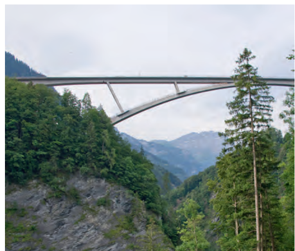
Fig. 2 Ansicht. Side view. (© Tiefbauamt Kanton St. Gallen)
