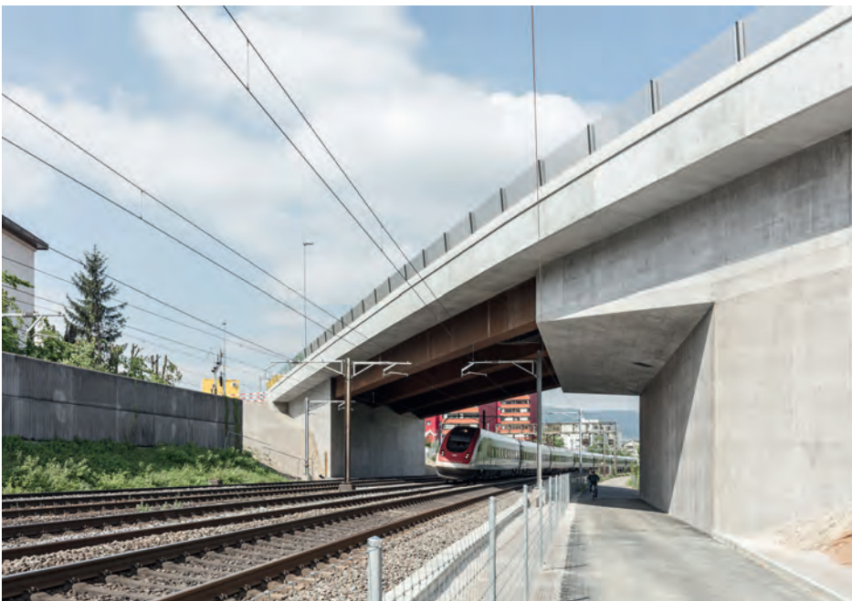
Fig. 1 Brücke und Rad-/Gehweg in Betrieb. Bridge and cycle and foot path in operation.
