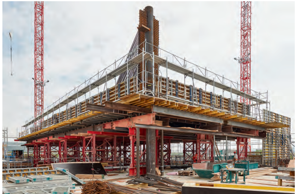
Fig. 3 Lehrgerüst und Krafteinleitungsdetail des Mitteltraktes. Falsework and force introduction detail of the central wing. (© Martin Stollenwerk)
