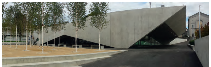
Fig. 7 Facciata Sud ed Est. North and east façades.
