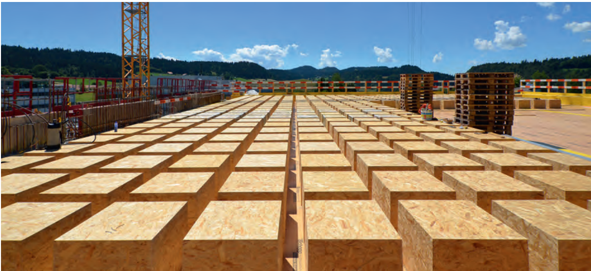
Fig. 5 Coffrage de la dalle cassette. Formwork for the cassette slab.
