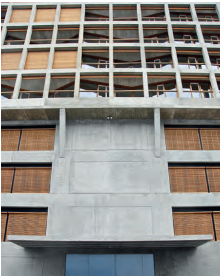
Fig. 9 Fassade Sockel mit Versatz und Ring zum Grid mit Balkonen. Base facade with offset and ring to the grid with balconies.
