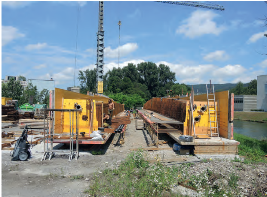
Fig. 3 Vorfabrizierte Längsträger vor dem Betonieren. Pre-fabricated longitudinal beams prior to concreting.
