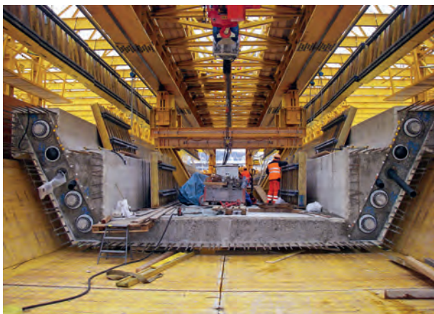
Fig. 2 Brückenquerschnitt der Letzigrabenbrücke im Bau. Cross-section of the Letzigraben bridge under construction.
