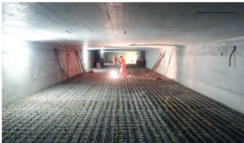
Fig. 6 Verstärkung untere Hohlkastenplatte im Randfeld. Strengthening of lower box girder slab in the edge area.
