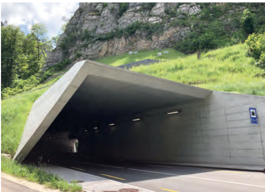
Fig. 2 Vue de l'ouvrage d'entrée nord. View of the north portal.
