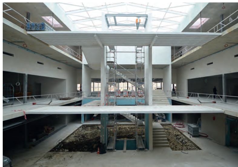
Fig. 4 Vue de l'atrium à la fin du gros œuvre. View of the atrium on completion of the structural work.
