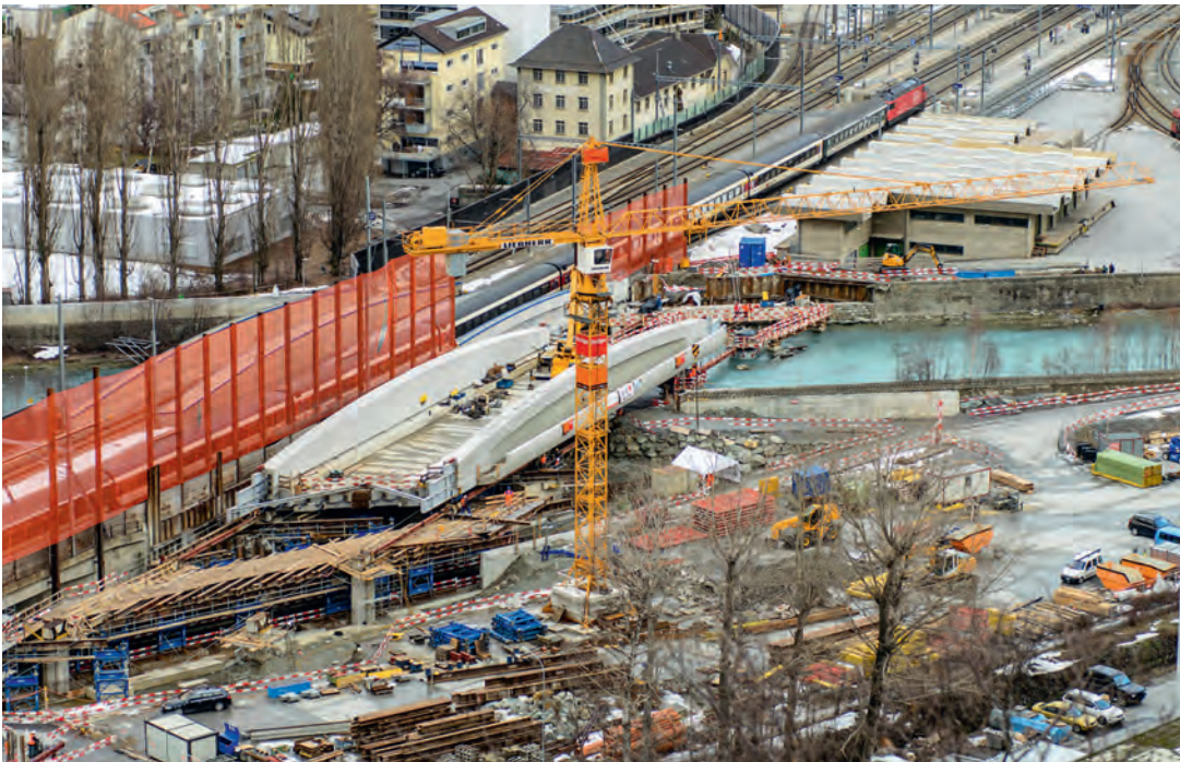
Fig. 8 Überbau kurz vor dem Ziel (im Vordergrund Reste des Lehrgerüsts). Superstructure just before the finish line (in the foreground, remains of the falsework).
