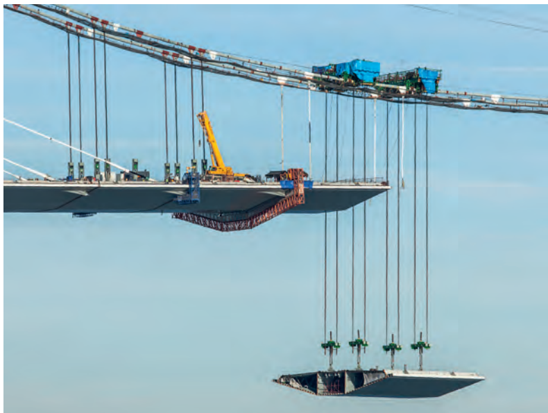
Fig. 9 Montage des éléments de la zone centrale au moyen de poutres de levage. Erection of the central segments with lifting gantries.
