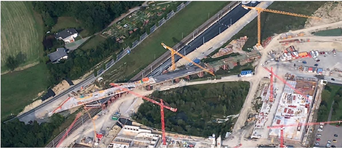
Fig. 10 Vue aérienne en état de construction. Aerial view during construction.
