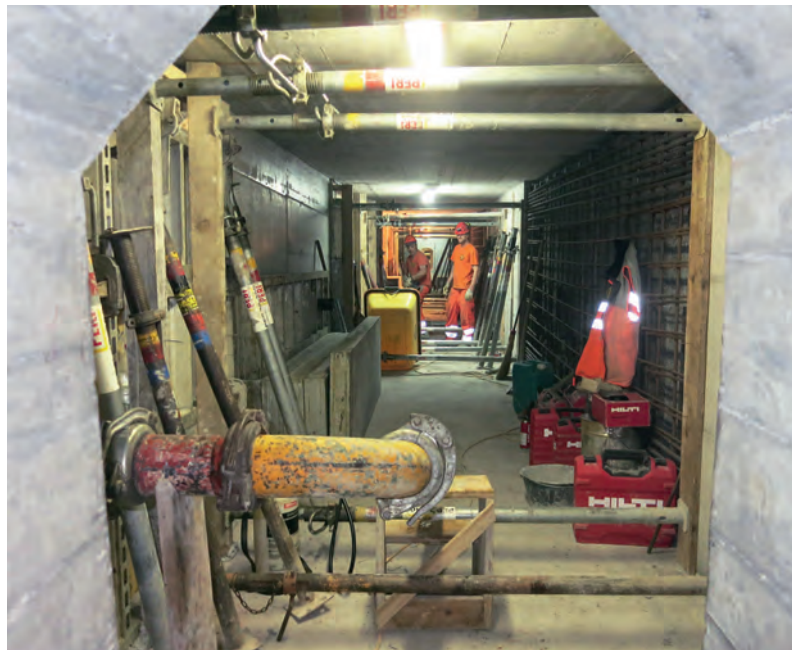
Fig. 6 Verstärkungsarbeiten im Hohlkasten. Reinforcement works in the box girder.
