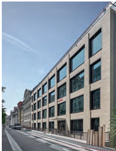
Fig. 1 Facciata lungo la Unterstrasse. Façade along Unterstrasse. (© Roger Frei)
