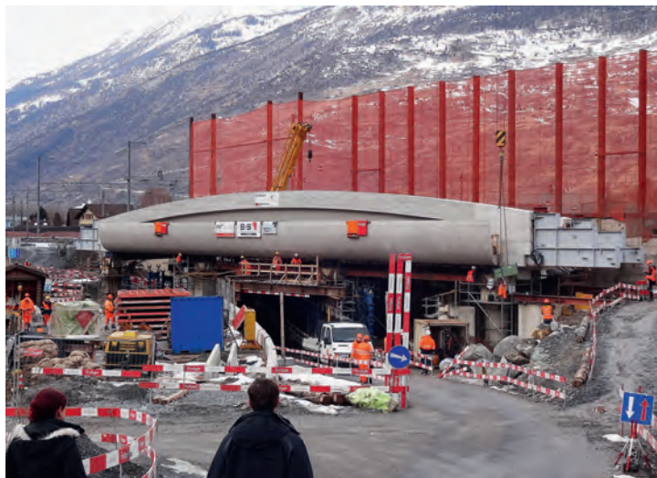
Fig. 6 Überbau bereit für den Längverschub. Superstructure ready for the longitudinal shift.
