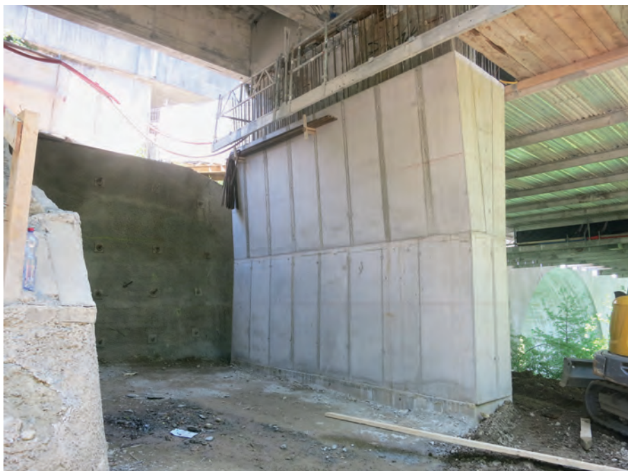
Fig. 7 Verstärkung der Stütze C. Strengthening of support C.
