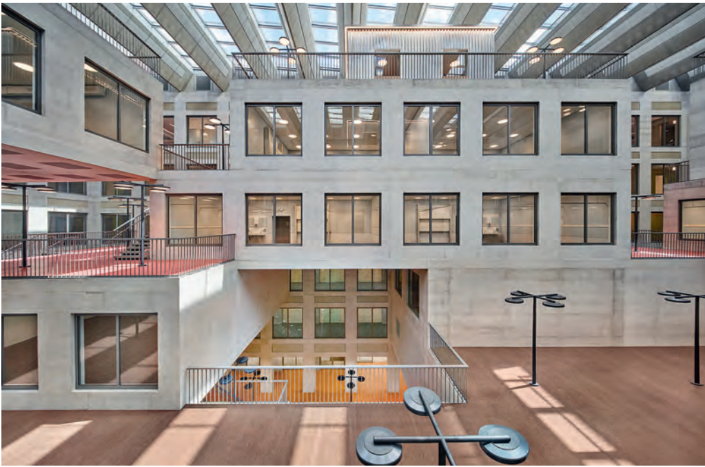
Fig. 4 Gestapelte Vierendeelträger und Wandscheiben im Atrium. Stacked Vierendeel beams and walls in the atrium. (© Luca Zanier)
