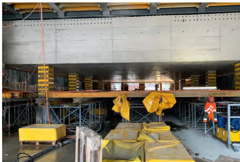
Fig. 7 Hochgepresste Decke über ursprünglichem Schaltsch. High jacked ceiling over the utilized formwork.
