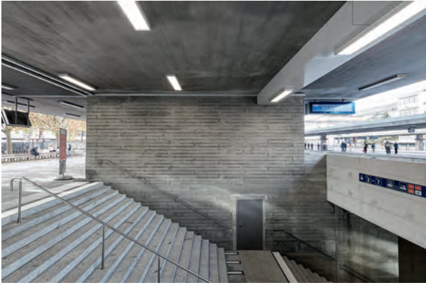
Fig. 3 Treppe im denkmalgeschützten Bahnhofgebäude. Stairs in the listed station building.
