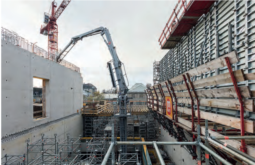
Fig. 2 Halle, 25 m hohe Sichtbetonwände, betoniert in 6-m-Etappen, mit Kletterschalung. Hall, 25 m high exposed concrete walls, concreted in stages of 6 m, with climbing formwork. (© Beat Bühler)
