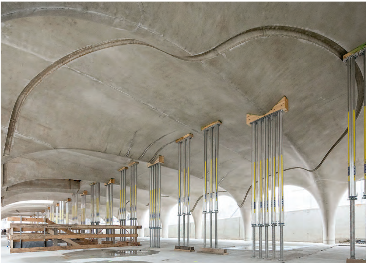
Fig. 5 Fertige Gewölbekonstruktion mit temporärer Spriessung im Bauzustand. Finished vault structure, temporary propping still in place. (© Philipp Zinniker)
