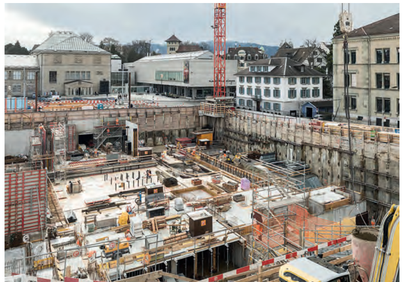
Fig. 5 Baugrube, Blick Richtung Unterquerung Heimplatz und bestehendes Kunsthaus. Excavation pit, view towards Heimplatz undercrossing and existing Kunsthaus. (© Beat Bühler)
