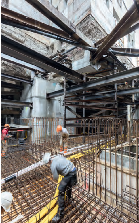
Fig. 7 Erstellung Unterquerungsbauwerk, 4. Etappe. Construction of the undercrossing, 4th stage. (© Beat Bühler)
