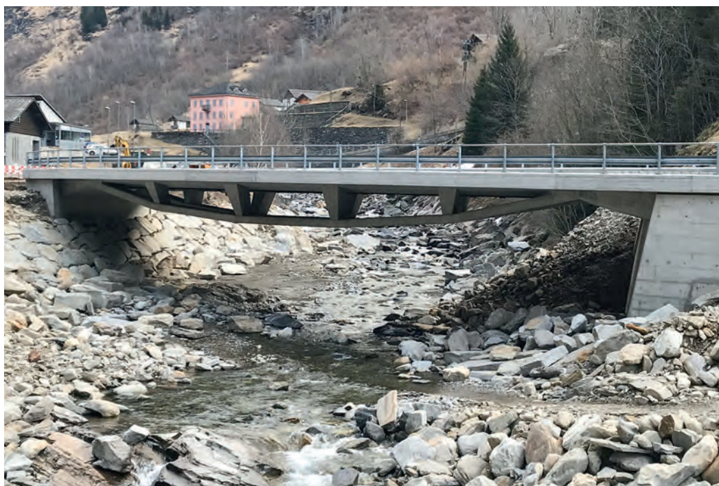
Fig. 6 Ansicht der Brücke Loveira. View of Loveira bridge.
