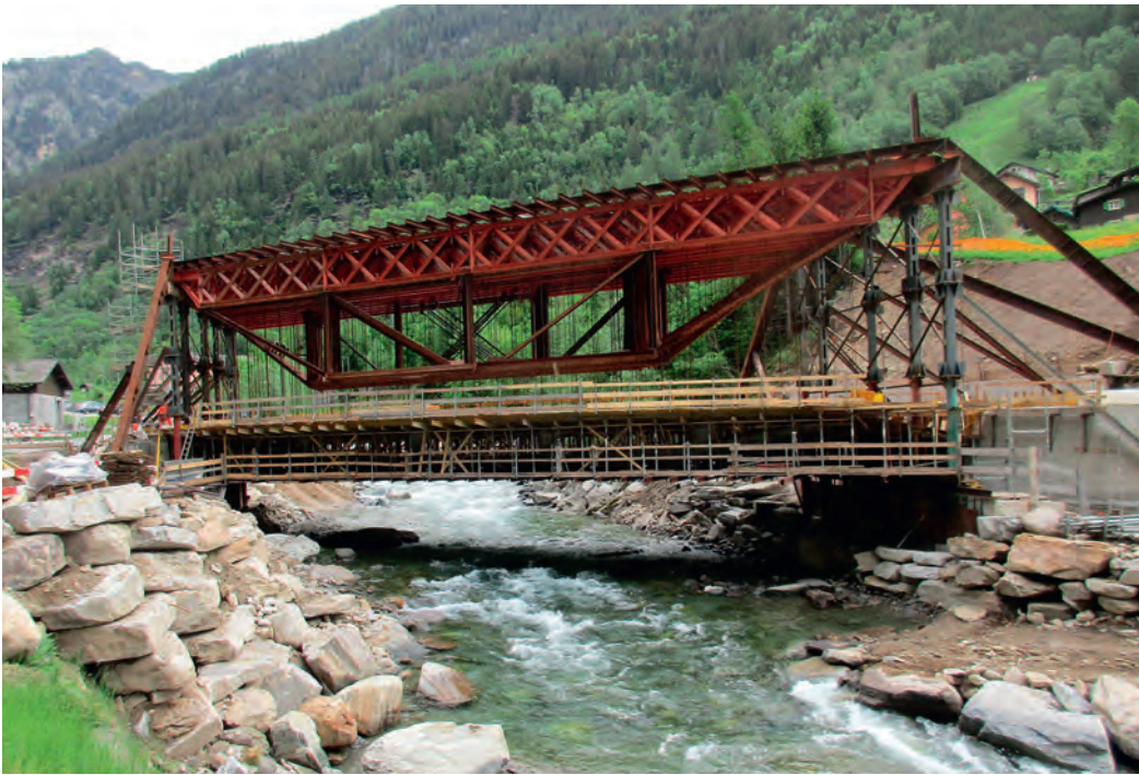
Fig. 8 Obenliegendes Lehrgerüst der Brücke Loveira. Overslung falsework of Loveira bridge.
