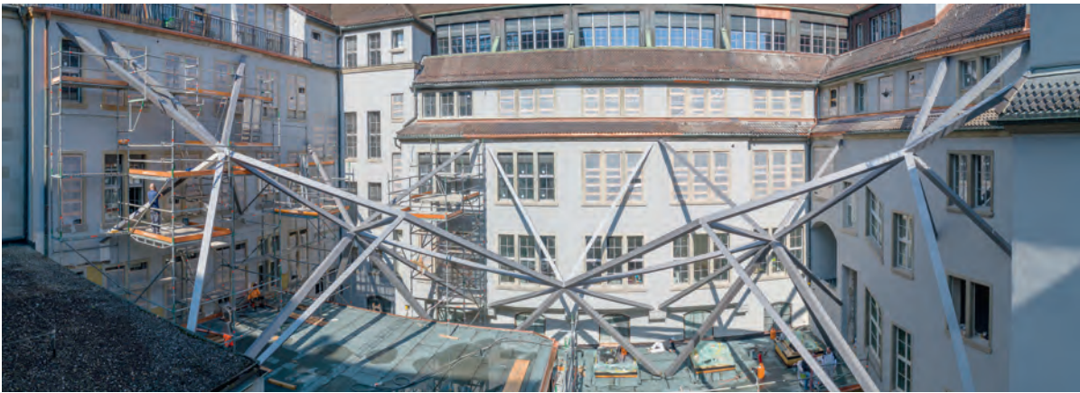
Fig. 3 Stahlstruktur im Innenhof. Steel structure inside the atrium.
