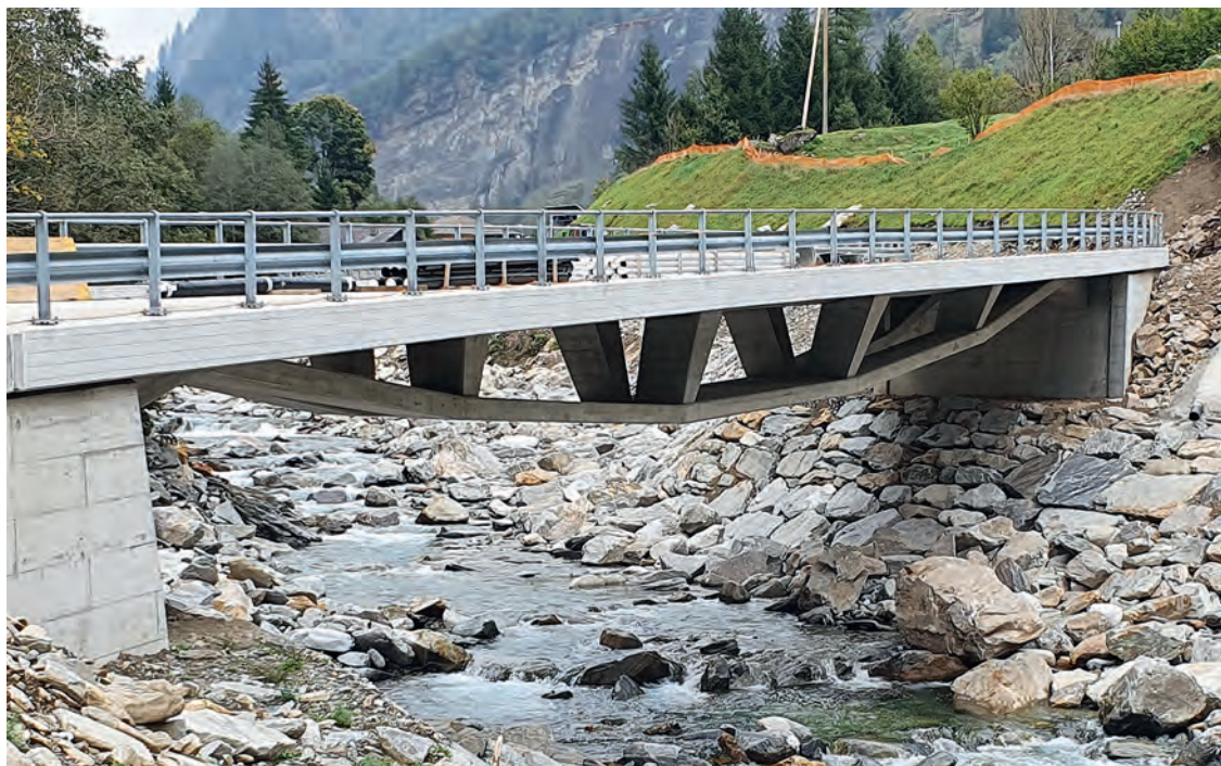
Fig. 5 Ansicht der Brücke Auriglia. View of Auriglia bridge.
