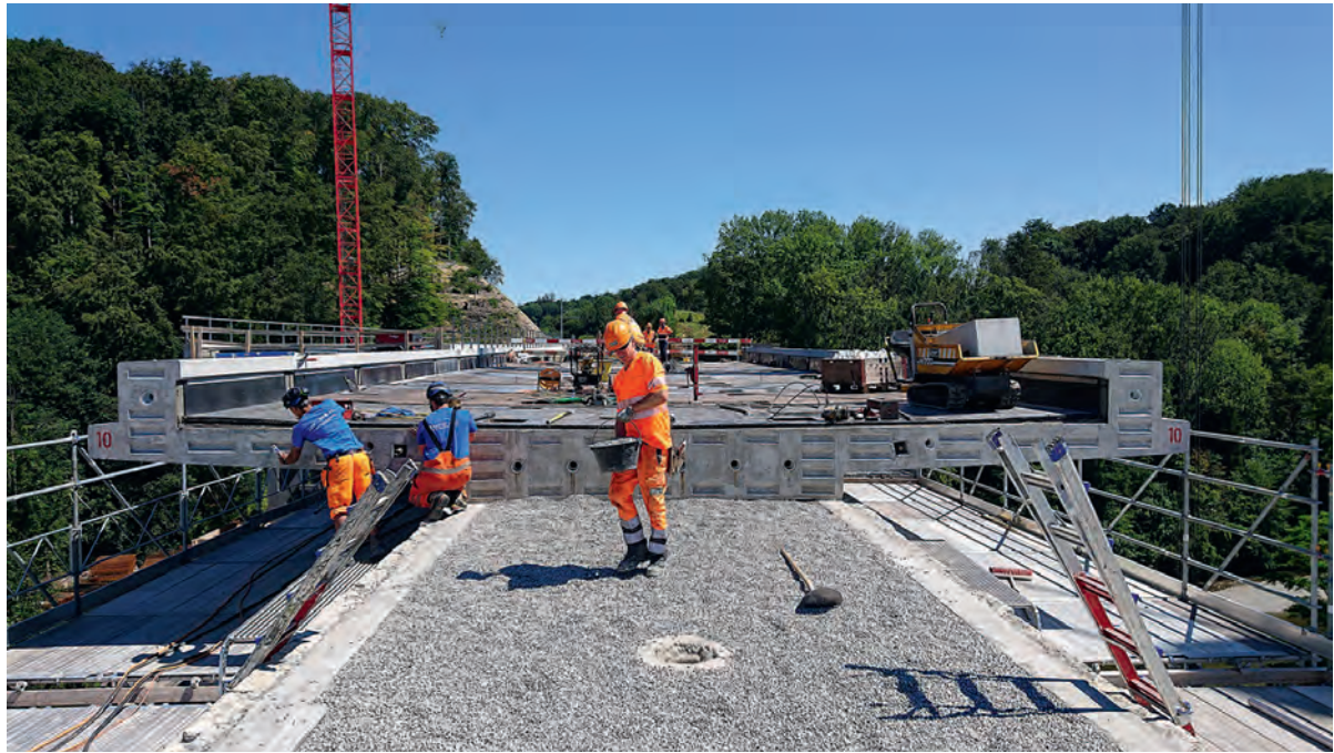
Fig. 5 Vorfabrizierter Schottertrog, Abschnitt West. Prefabricated gravel trough, west section.
