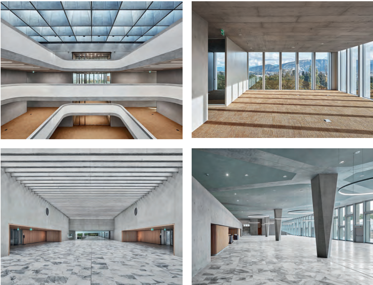
Fig. 7 Intérieur du bâtiment final (atrium avec grille de poutres, dalle en porte-à-faux, foyer, dalle de restaurant). Interior of finished building (atrium with grid beams, cantilevered slab, foyer, restaurant slab). (© Damian Poffet)
