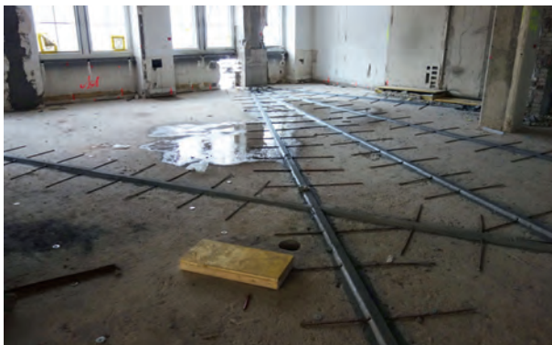
Fig. 4 Vorgespannte CFK-Bänder. Post-tensioned CFRP strips.
