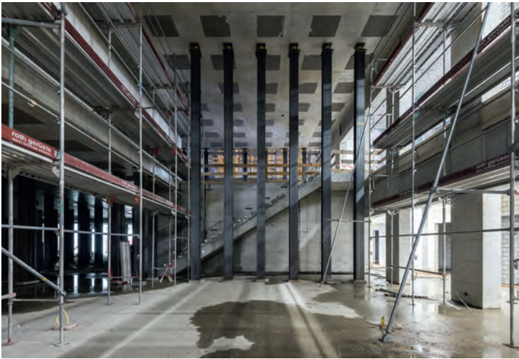
Fig. 7 Spriessung mit 10 m langen Stahlprofilen (HEA 300) und hydraulischen Pressen im Bauzustand. Bracing using 10 m long steel struts (HEA 300) and hydraulic presses at top of struts during construction. (© Beat Bühler)
