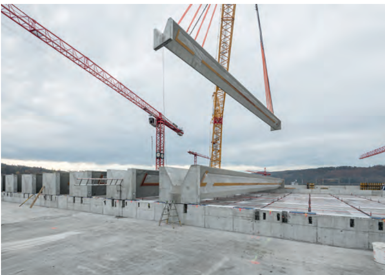
Fig. 5 Versetzen der 30 m langen vorgefertigten Dachträger. Lifting of the 30 m long prefabricated roof beams. (© Beat Bühler)
