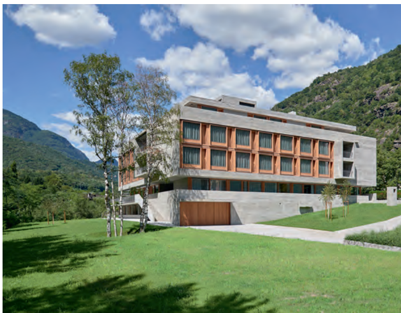
Fig. 2 Vista da sud dove è ben visibile il giunto creato dal camminamento periferico. View from the south where the joint created by the perimeter path is clearly visible. (© marcelo villada ortiz)
