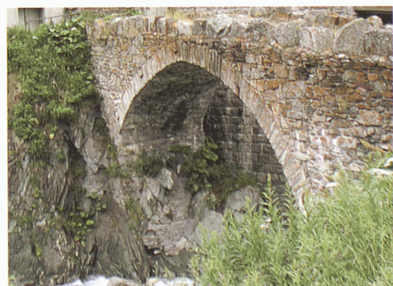
Pont à Wassen, Uri
