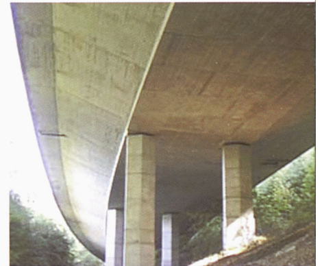
Vues du caisson de Pont du Cucloz
