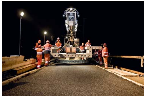
Fig. 5 Einbau vorfabrizierter Schottertrög am Viadukt Val Rabius. Installation of prefabricated ballast trough on the Val Rabius viaduct. (© Andrea Badrutt)
