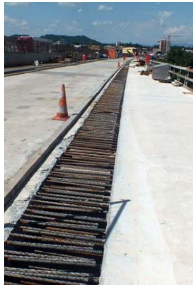
Fig. 9 Vor dem Fugenschluss (Foto Astra). Before the joint sealing (Photo Fedro).
