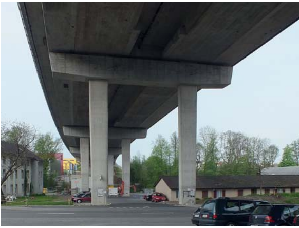
Fig. 6 Untersicht der verbreiterten Brücke (Foto Astra). Overview of the widened bridge (Photo Fedro).
