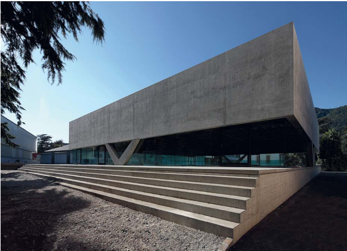
Fig. 8 Facciata Sud (© Filippo Simonetti). South Façade (© Filippo Simonetti).
