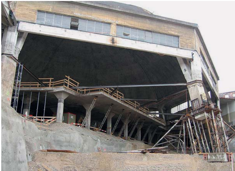
Fig. 4 Bauzustand für die Erstellung neuer Kellerräume. Abfangung der Hauptstütze Nr. 5. Construction site during the construction of new basement levels. Temporary support of the main column No. 5.
