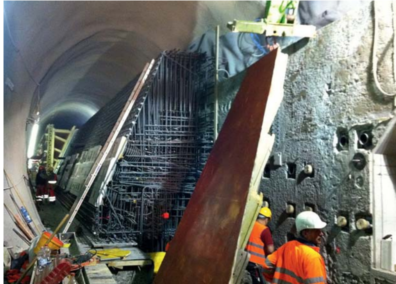
Fig. 5 Bewehrung und Schalung des Endträgers. Reinforcement and formwork of the end beam.
