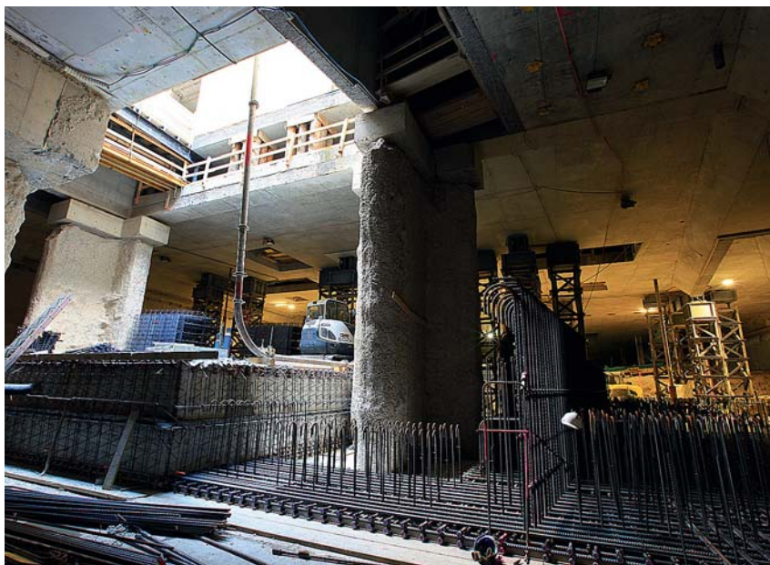
Fig. 6 Schlitzwandpfeiler. Diaphragm wall pillar. (© Marco Püntener)
