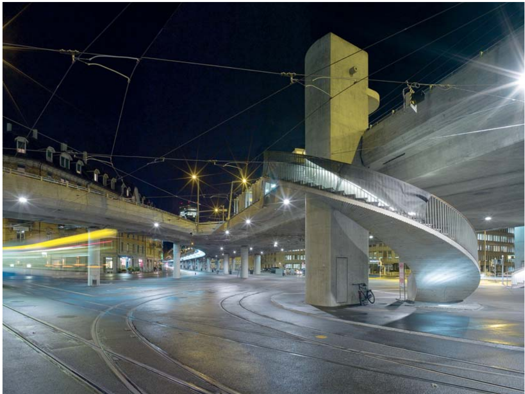
Fig. 7 Treppenaufgang am Escher-Wyss-Platz (Boesch Architekten). Staircase at Escher-Wyss-Platz (Boesch Architekten).
