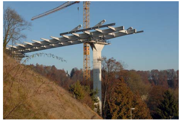
Fig. 12 Ossature métallique Palatinat mise en œuvre par lancement. Palatinat side: steel framework for the balanced cantilever method.
