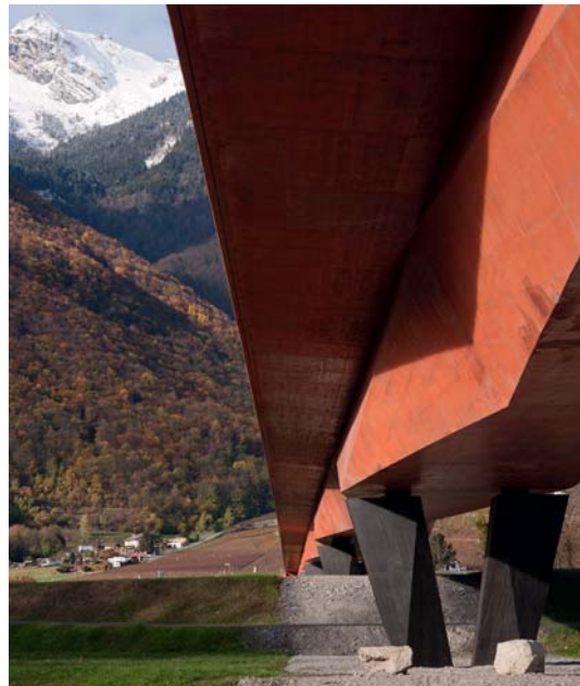
Fig. 3 Tablier, âmes et piles de l'ouvrage. Bridge floor, webs and piers of the structure. (© Yves André)
