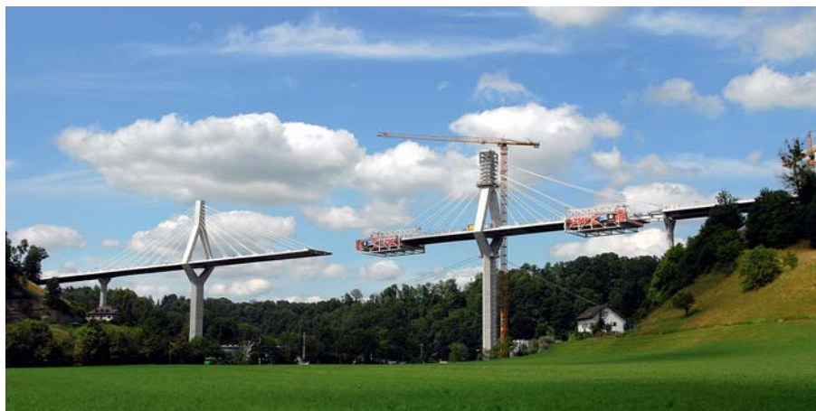
Fig. 10 Stabilisation diagonale provisoire du fléau 7. Provisional diagonal stabilisation of beam 7.
