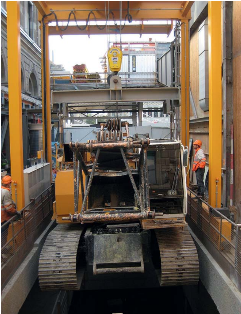
Fig. 7 Einbringen des Schlitzwandgeräts mit dem Portalkran. Installing the diaphragm wall equipment with the gantry crane. (© Marco Püntener)
