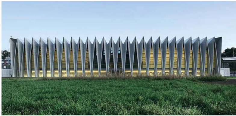
Fig. 3 Ansicht der Sporthallen von der Aareseite: Das durchgehende Foyer unterhalb der zwei Dreifachhallen ist gut erkennbar. View of the sports hall from the river side: the foyer underneath the two triple gyms is recognisable. (© Kanton Aargau, Foto: René Rötheli, Baden).
