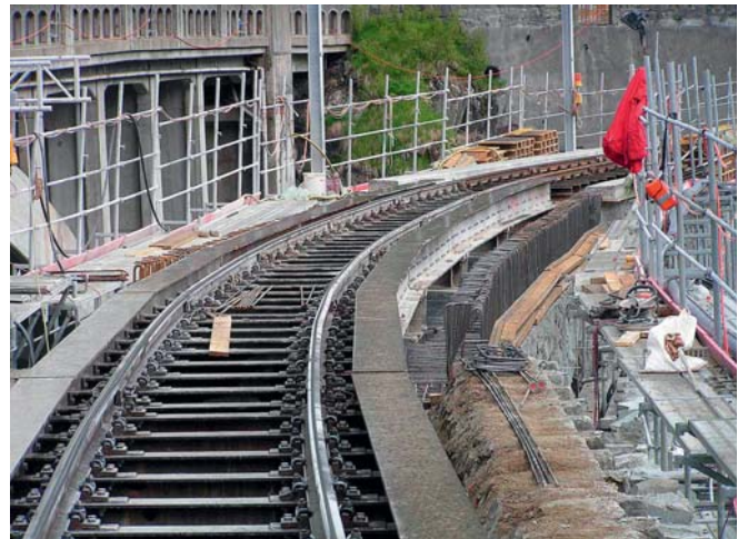
Fig. 3 Herstellung Schottertrug Russeiner viadukt. Production of the ballast trough on the Russeiner viadukt.
