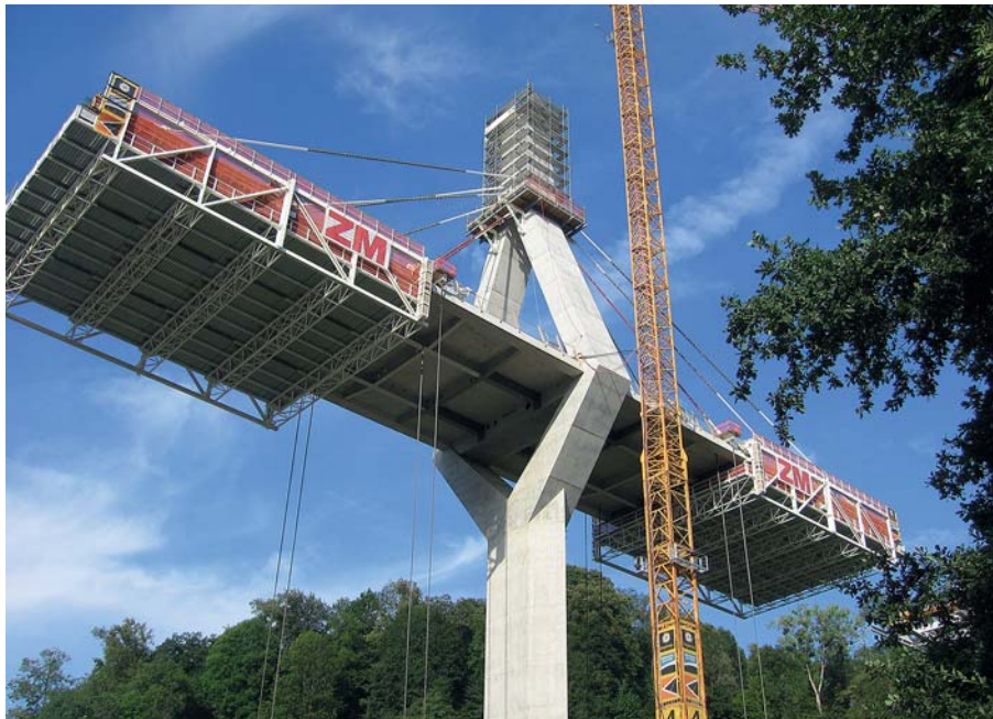
Fig. 9 Stabilisation verticale provisoire du fléau 6. Provisional vertical stabilisation of beam 6.
