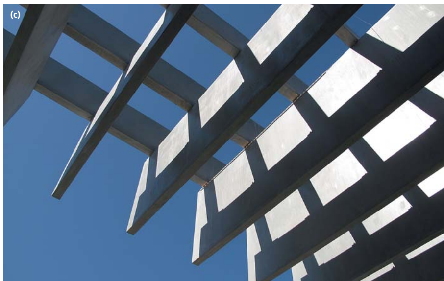
Fig. 1 a) Façade sud du Musée Olympique et nouvelle toiture pendant les travaux, b) vue vers le lac depuis l'intérieur et c) vue de la partie fonctionnant comme brise-soleil. a) South facade of the Olympic Museum and new roof during construction, b) view towards the lake, and c) view of the canopy.
