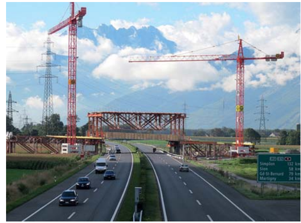
Fig. 9 Cintre disposé au-dessus du tablier pour le franchissement de l'A9. Overhead spanning falsework for the crossing of the A9.
