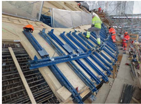
Fig. 11 Befestigen der Konterschaltung. Fixing the upper formwork.
