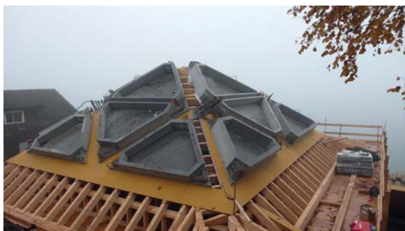
Fig. 4 Cassero e elementi prefabbricati copertura. Formwork and prefabricated roofing elements.
