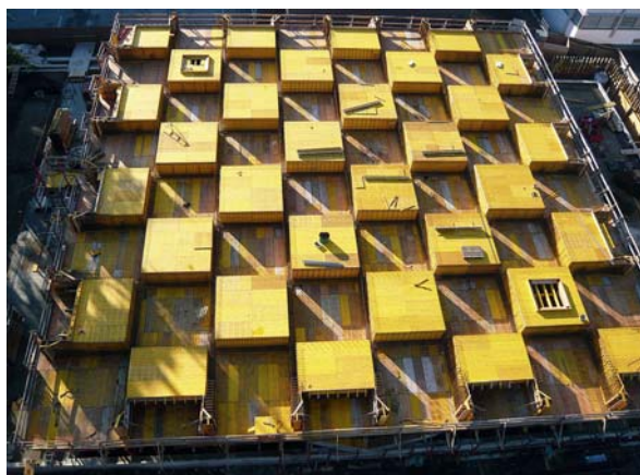
Fig. 9 Casseratura graticcio di copertura. Roof lattice formwork.
