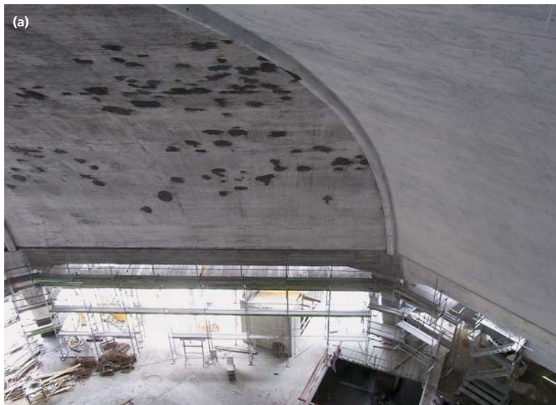
Fig. 6 a) Kuppelschale vor und nach der Betonreparatur. b) Hauptstütze Nr. 4 mit ergänzter Bewehrung vor der Reprofilierung. a) Dome shell before and after the concrete renewal. b) Main column No. 4 with additional reinforcement before cover concrete was reapplied.
