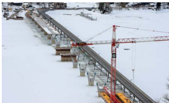
Fig. 9 Baustelle mit Arbeiten am Überbau Teil 2, Winter 2013. Construction site with work on second half of superstructure, winter 2013.
