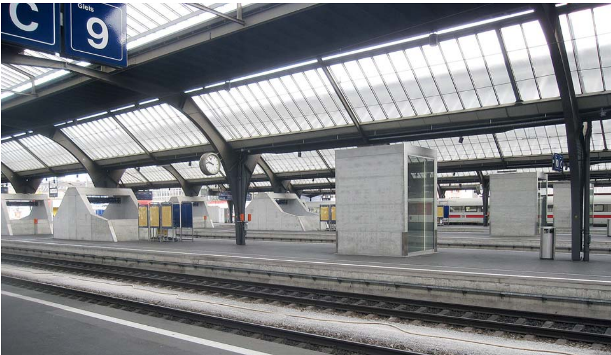
Fig. 8 Sichtbetonbauteile mit anspruchsvollen Formen bilden die Abgänge aus der Perronhalle. Fair-faced components with demanding shapes form the exits from the platform hall.
