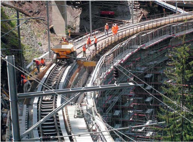
Fig. 4 Herstellung Schottertrug Lochtobelviadukt. Production of the ballast trough on the Lochtobel viaduct.
