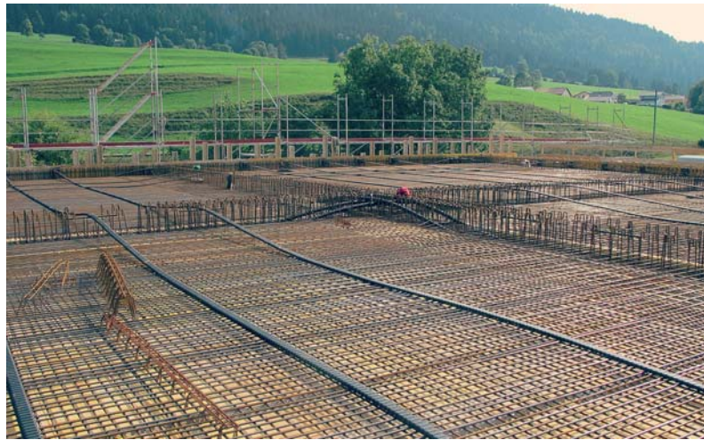
Fig. 7 Pose de la précontrainte. Installing the pre-stressing.
