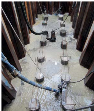
Fig. 5 Blick in einen Spundwandkasten mit Pfahlköpfen beim Auspumpen. View inside a sheet pile caisson with pile heads.
