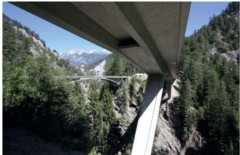
Fig. 2 Untersicht der Brücke mit Übergang vom offenen Plattenbalken zu Hohlkasten. View from below the bridge with transition of T-beam section to box girder.
