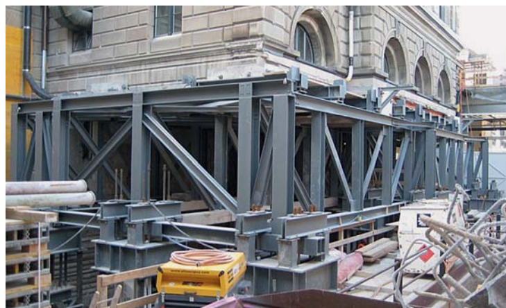
Fig. 5 Stabile Abfangung des Südwesttrakts mit einem räumlichen Fachwerk. Stable underpinning of the southwest wing with a space frame. (© Marco Püntener)
