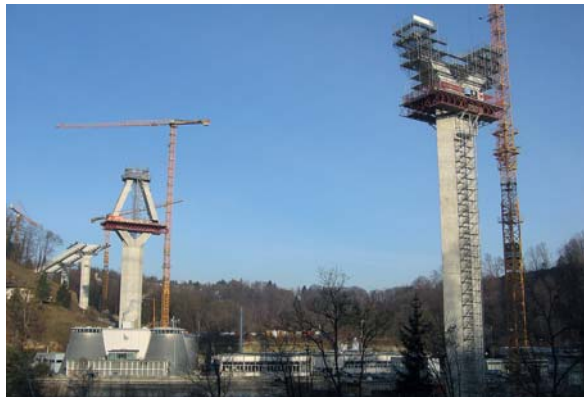
Fig. 11 Montage des mâts 6 et 7. Assembly of pylons 6 and 7.
