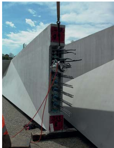
Fig. 10 Vorspannung der Stiele im Werk, Ankersnische und Stahl-Fussplatten. Post-tensioning of the column beams at the factory, block-out and steel base plates. (© VSL AG, Subingen).
