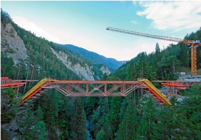
Fig. 6 Lehrgerüst mit 6 m hohem Fachwerk-Einhängeträger. Falsework with 6 m deep truss girder. (© P. Vonow)
