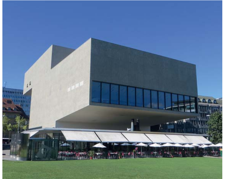
Fig. 3 Le côté parc avec l'auditoire de 700 places surplombant le restaurant. The park side with the 700-seat auditorium overhanging the restaurant.
