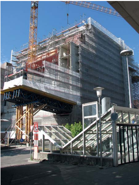
Fig. 7 Stabilisation des étapes de construction côté parc. Supporting the construction steps on the park side.
