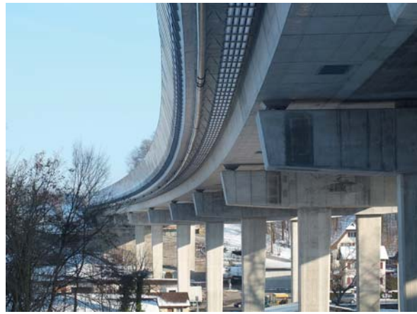
Fig. 7 Nordseite (Foto Astra). North side (Photo Fedro).
