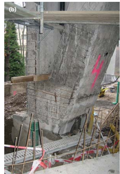
Fig. 6 a) Kuppelschale vor und nach der Betonreparatur. b) Hauptstütze Nr. 4 mit ergänzter Bewehrung vor der Reprofilierung. a) Dome shell before and after the concrete renewal. b) Main column No. 4 with additional reinforcement before cover concrete was reapplied.
