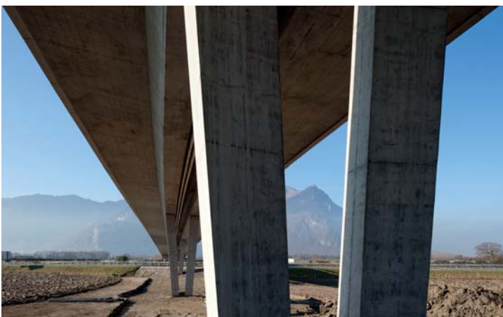
Fig. 4 Vue de la pile et de l'intrados du tablier. View of the pier and the soffit of the bridge floor. (© Yves André)
