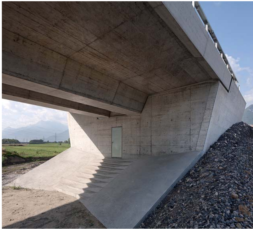
Fig. 6 Vue de la culée. View of the abutment. (© Yves André)
