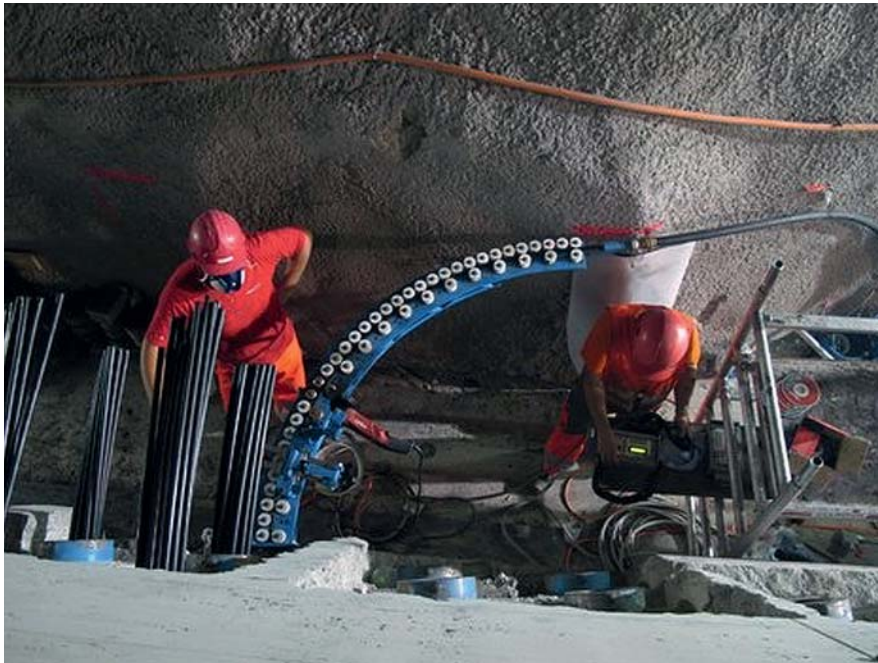
Fig. 6 Einstossen der Monolitzen mit spezieller Umlenkvorrichtung. Installation of monostrands with deviation device.
