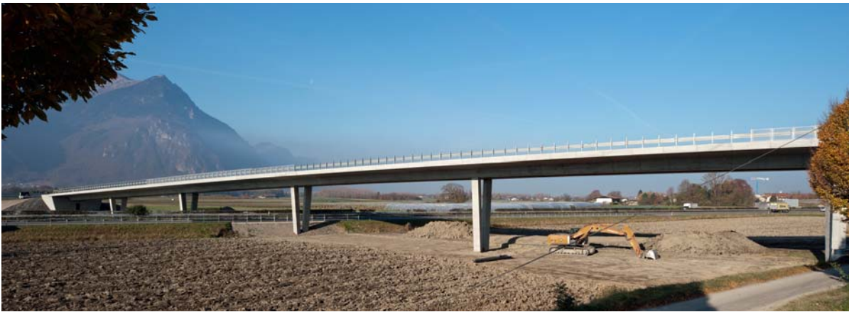
Fig. 10 Vue d'ensemble. General view. (© Yves André)
