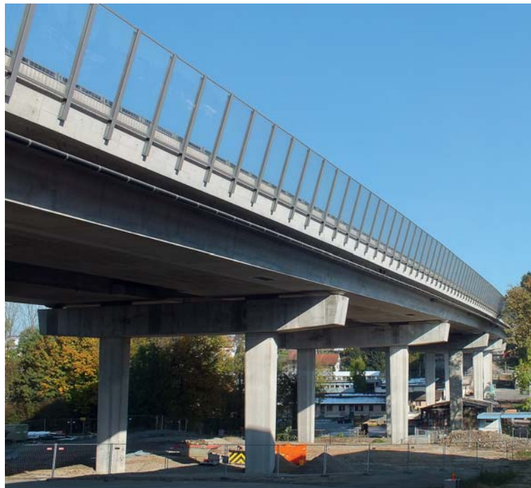
Fig. 4 Fertiggestellte Brücke, Südseite (Foto Astra). Finished bridge, south side (Photo Fedro).
