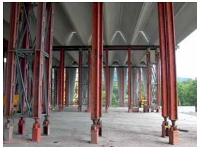
Fig. 6 Gerüsttürme für die temporäre Abstützung der Dachträger. Temporary support of the roof beams using falsework.
