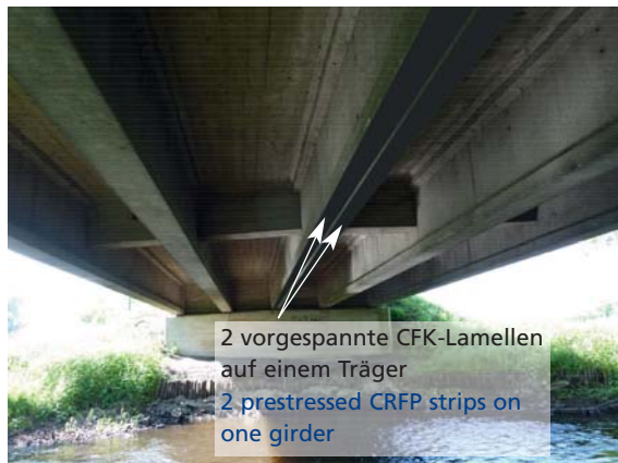
Fig. 7 Brücke mit 5 Spannbetonträgern in Polen. Five-girder bridge in Poland.
