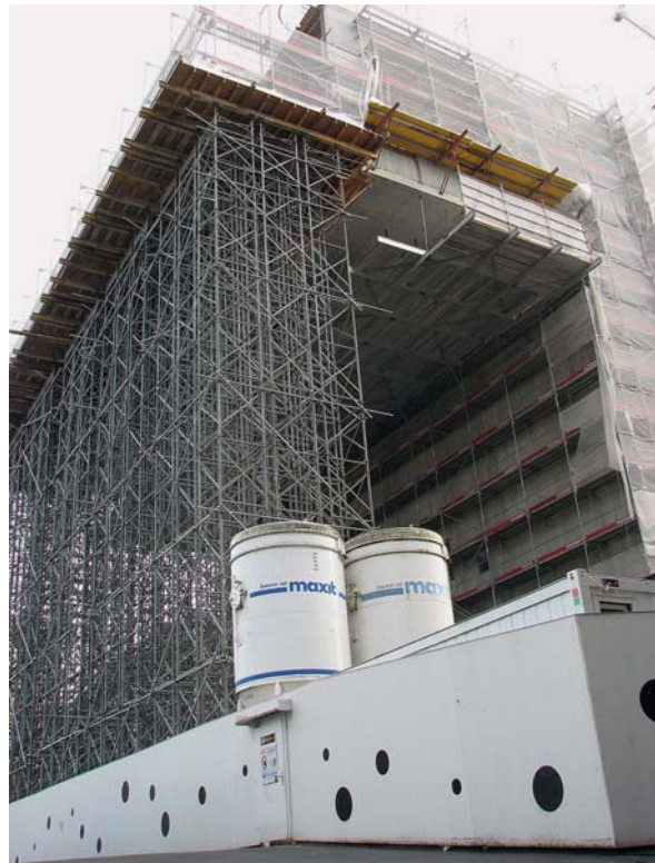
Fig. 8 Construction traditionnelle avec échafaudage. Conventional building with falsework.
