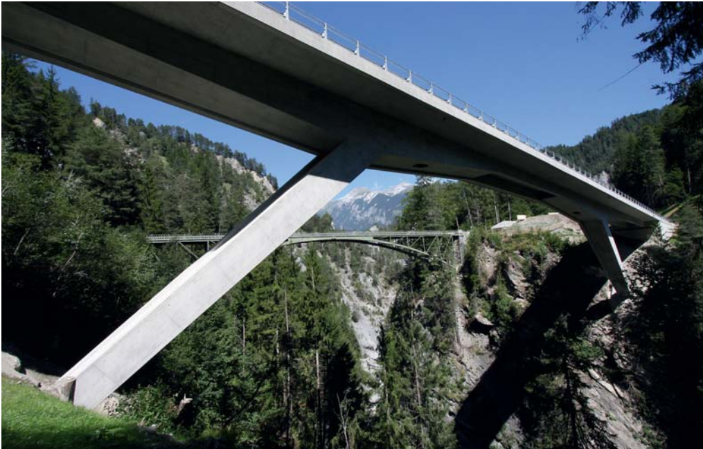
Fig. 1 Neue Versamertobelbrücke mit bogenförmiger Stahlfachwerkbrücke (Jahr 1897) im Hintergrund. New Versam Gorge bridge with arched, steel-truss bridge (built 1897) in the background.
